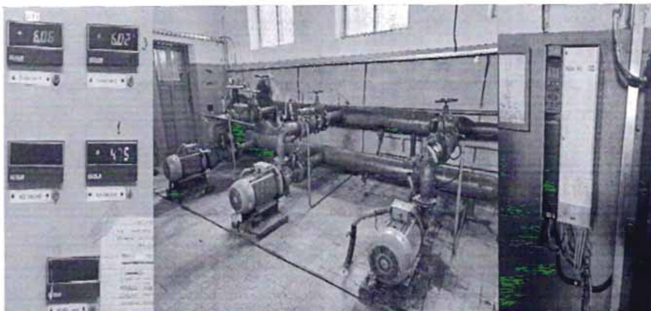
Fig. 1. Pompele, convertizorul de frecvență, panoul de monitorizare a parametrilor de la SP „Botanica”
